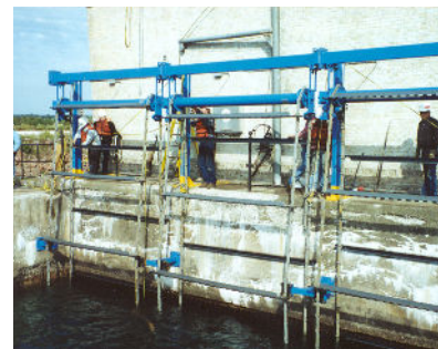
Montage sur poutrelle en I pour le modèle Grille uniquement
